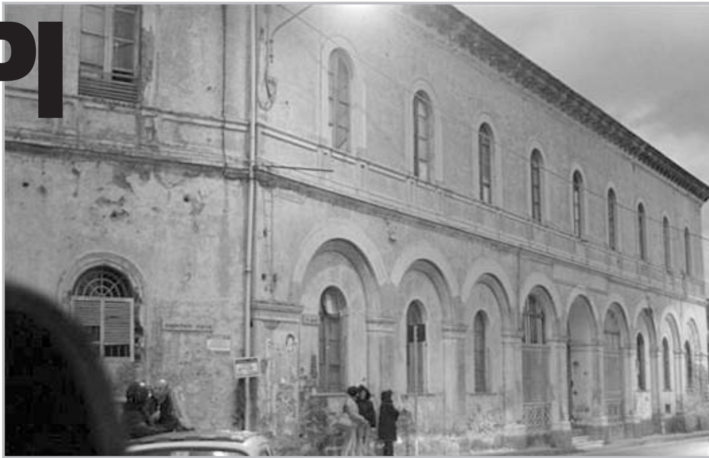
L'ex Umberto I, per il quale dovranno partire i lavori di riqualificazione
